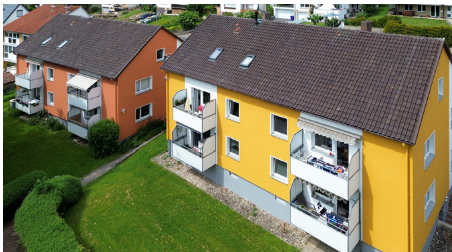
Berliner Straße 9 & 11 Alfeld
