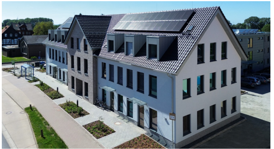
Berliner Straße 27 Schellerten
