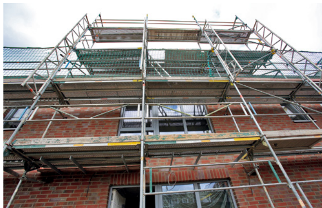
In Hohenhameln entsteht im Dehnenweg ein Mehrfamilienhaus mit 15 Wohnungen.
