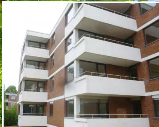
So sah es kurz vor der Modernisierung im Mai 2018 aus, die Bagger standen schon bereit.
