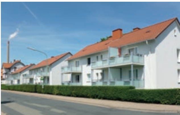
Balkonanbau Ziegelmarsch 13-15, Alfeld
