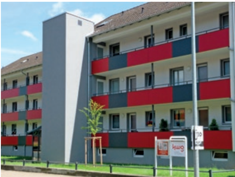
Aufzugsanbau Dohnser Weg 7, Alfeld
