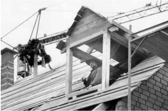
Richtfest der Kreiswohnbau in Hildesheim-Itzum am 12. Dezember 1991 mit dem Polier Bernhard Rosenbaum von der Baufirma Thiemt aus Bad Salzdetfurth
