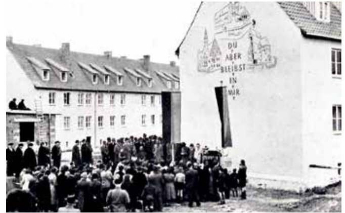
Übergabe von 54 Wohnungen an Flüchtlingsfamilien aus den deutschen Ostgebieten am 1. Mai 1951 in Sarstedt. Die Wohnungen waren im „Baracken-Programm“ entstanden, das heißt die neuen Mieter lebten bis dahin in unwirtlichen Baracken
