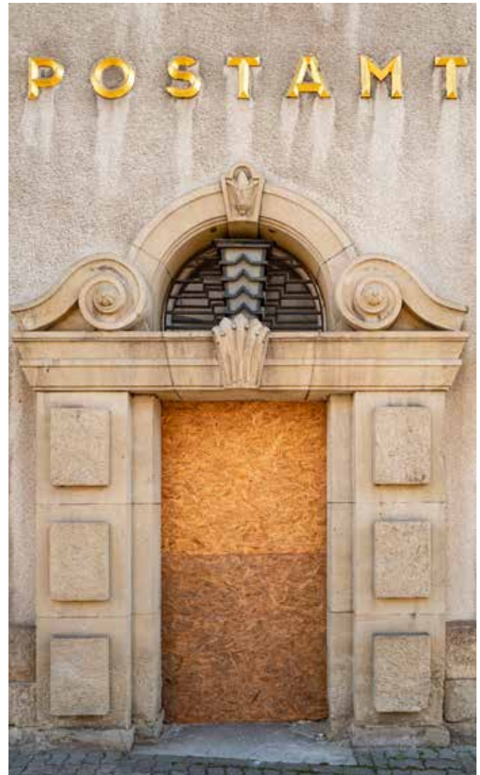
Die Sanierung der Alten Post in Alfeld, Fotografie vom 10. Mai 2023.
