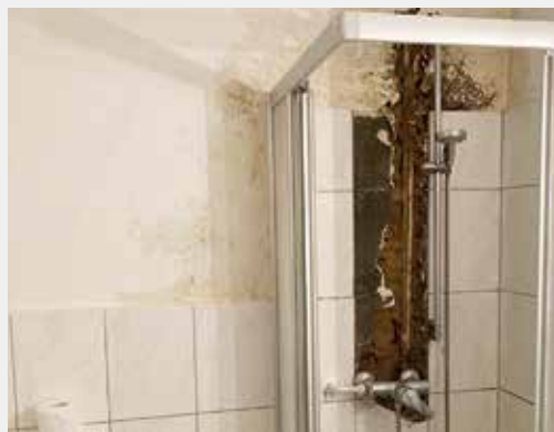
2 Manchmal muss die Wand aufgestemmt werden.
