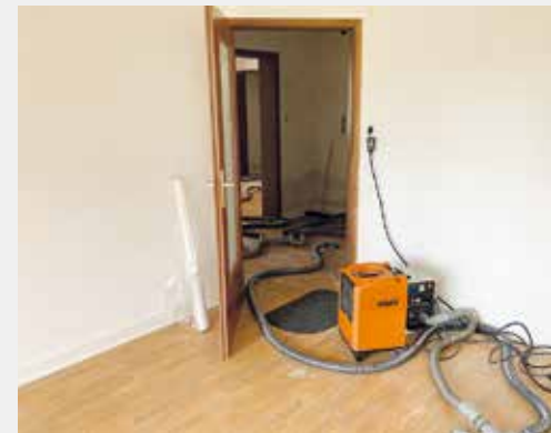
6 Trocknereinsatz gegen die Feuchtigkeit im Fußboden.
