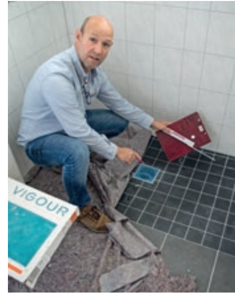
Michael Vollmers begutachtet die Arbeiten im neuen barrierearmen Duschbad: „Die Fliesen in der Dusche sind rutschfest.“
